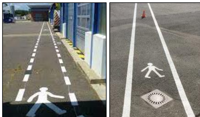
EXEMPLE DE MARQUAGE DE CHEMINEMENT PIETON SIMPLE
