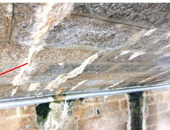
Les travaux de reprise d'étanchéité du tablier sont nécessaires pour garantir la pérennité de l'ouvrage.
