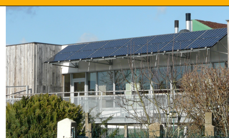
Panneaux solaires jouant le rôle de brise soleil sur une façade orientée sud
