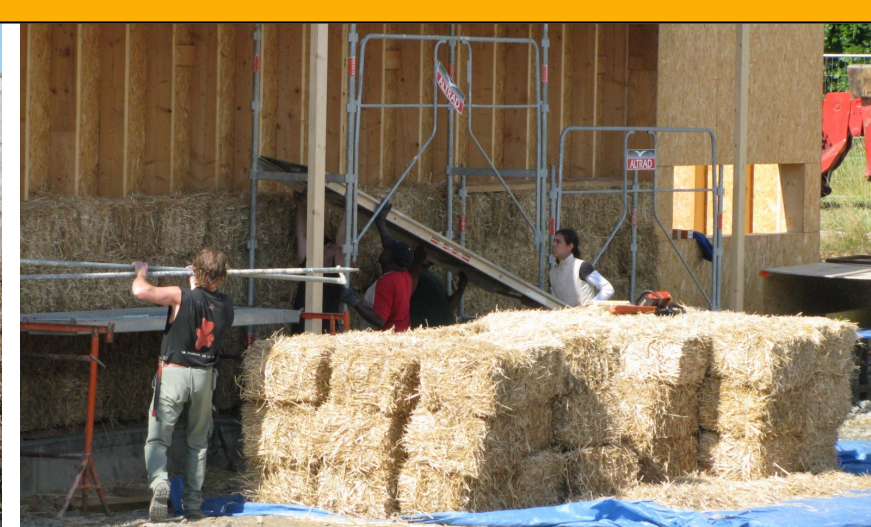
Chantier d'isolation par l'extérieur à l'aide de matériaux naturels et locaux (paille)
