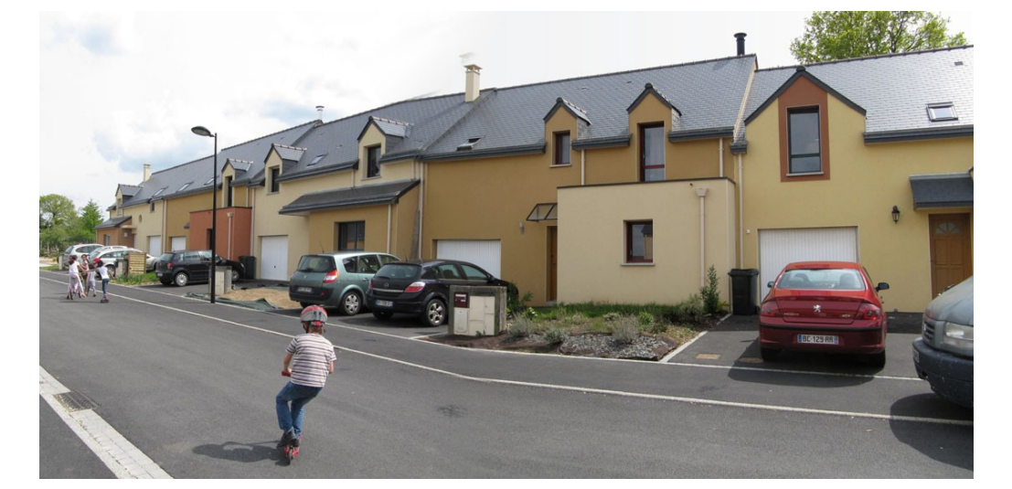
Constructions sur des lots libres denses maîtrisées par prescriptions architecturales logements
