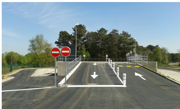
Les deux sens de circulation pour accéder au quai de déchargement
